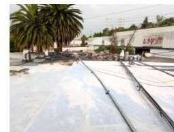
Aplica un tramo corto de Sellador Texturizado y fija la Membrana sin arrugas o bolsas.
