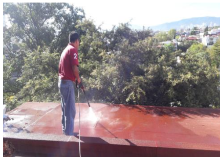
Limpieza de lodo
