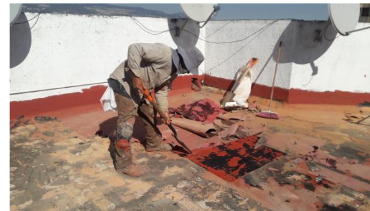
Retiro de membrana suelta
