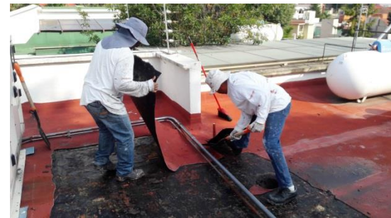
Retiro de tapete sin adherencia
