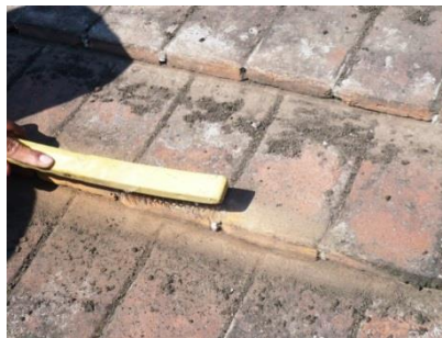
Cepillado de moho
