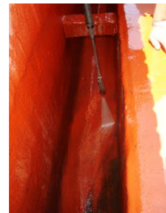
Limpieza de grasa
