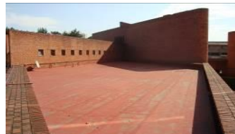
Sellador Texturizado y colocación simultánea de Membrana.
