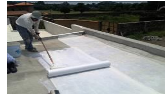
Sellador Texturizado y colocación simultánea de Membrana.
