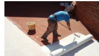
Sellador Texturizado y colocación simultánea de Membrana.
