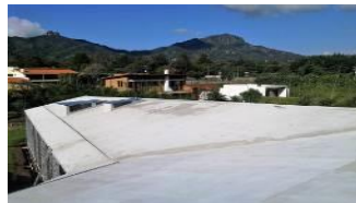
Sellador Texturizado y colocación simultánea de Membrana.
