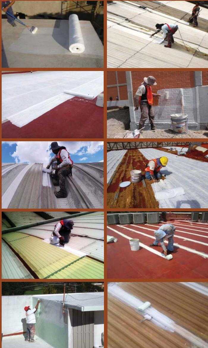
*Conforma la Capa Primaria de Anclaje y Refuerzo, para la aplicación de Impermeabilizante en opciones económicas y en aplanados de fachadas con fisuras.*
