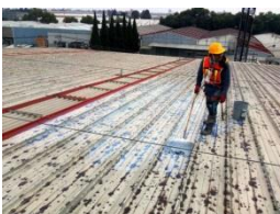
Sellado acrílico de la superficie – Aplicación de Mortero Acrílico y colocación simultánea de Membrana de Refuerzo de Poliéster en toda la superficie.
