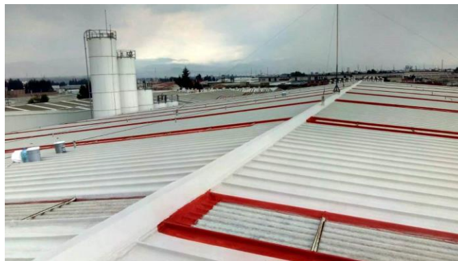
Aplicación de Segunda mano de Mortero Acrílico (en opción 7 años) y acabado a dos manos de Reflejante Acrílico Imperlasa en color gris perla.
