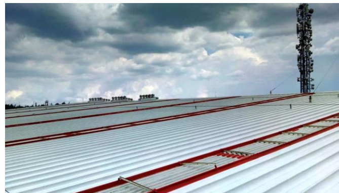
Aplicación de Segunda mano de Mortero Acrílico (en opción 7 años) y acabado a dos manos de Reflejante Acrílico Imperlasa en color gris perla.
