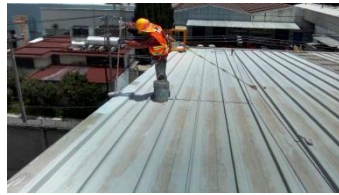
Aplicación de Segunda mano de Mortero Acrílico (en opción 7 años) y acabado a dos manos de Reflejante Acrílico Imperlasa en color gris perla.
