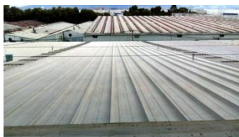
Aplicación de Segunda mano de Mortero Acrílico (en opción 7 años) y acabado a dos manos de Reflejante Acrílico Imperlasa en color gris perla.
