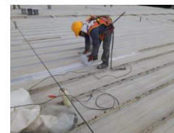
Sellado acrílico de la superficie – Aplicación de Mortero Acrílico y colocación simultánea de Membrana de Refuerzo de Poliéster en toda la superficie.
