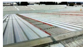
Sellado acrílico de la superficie – Aplicación de Mortero Acrílico y colocación simultánea de Membrana de Refuerzo de Poliéster en toda la superficie.
