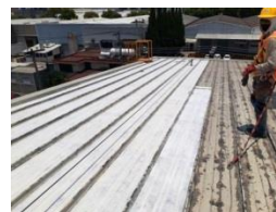
Sellado acrílico de la superficie – Aplicación de Mortero Acrílico y colocación simultánea de Membrana de Refuerzo de Poliéster en toda la superficie.
