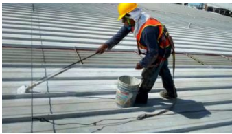
Aplicación de Segunda mano de Mortero Acrílico (en opción 7 años) y acabado a dos manos de Reflejante Acrílico Imperlasa en color gris perla.
