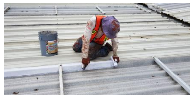
Aplicación de Mortero y Fijación puntual de Membrana
