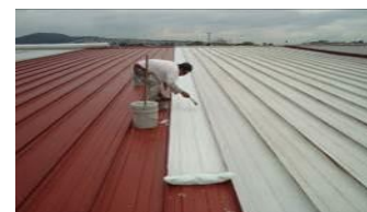
Aplicación de Mortero y Fijación puntual de Membrana
