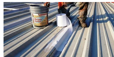
Aplicación de Mortero y Fijación puntual de Membrana
