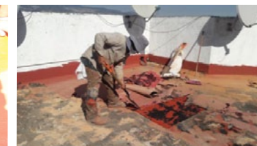
Retiro de Material Suelto.
