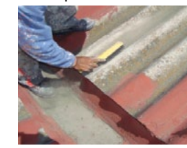
Cepillado de Moho.
