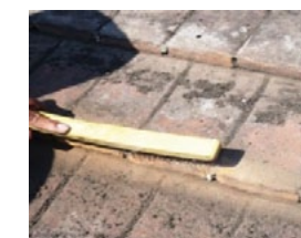
Cepillado de Moho.
