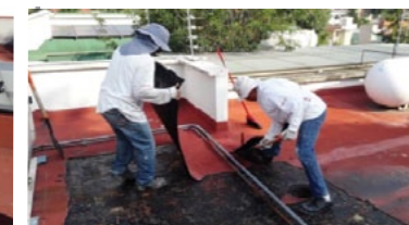
Retiro de Material Suelto.
