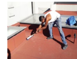
Barrido de Gravilla y Tierra.
