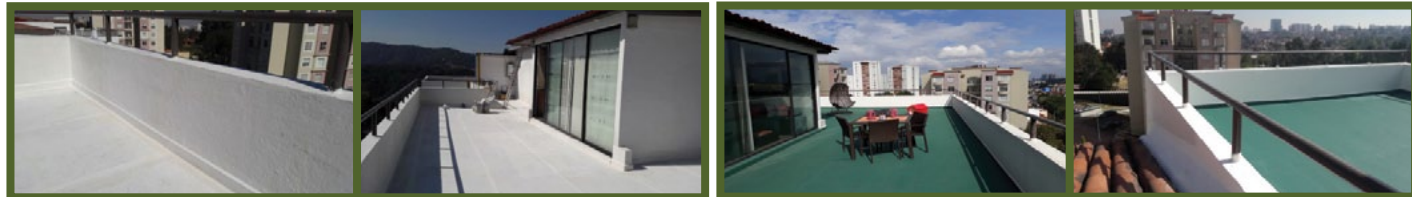
Forrado integral de losa, zoclo y pretiles.
