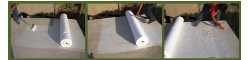
Aplicación de Mortero y colocación de Membrana. Acabado a dos manos de Reflejante Impermeabilizante.
