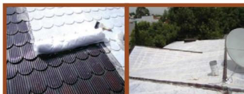
Aplicación de Sellador Texturizado y colocación de Membrana.
