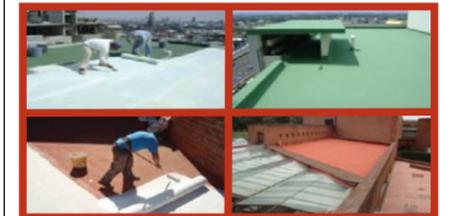
imperlasa®, sistema impermeabilizante acrílico base agua, es la solución real a problemas de filtración y humedad en techos, muros y azoteas en **aplicación expuesta** (No se recomienda su uso en superficies que recibirán acabados de piso, deck o jardineras); se requiere superficie firme, limpia y seca.
