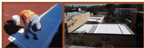
Aplicación de Sellador Texturizado y colocación de Membrana.
