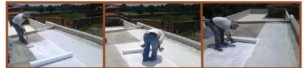
Aplicación de Mortero y colocación de Membrana.
