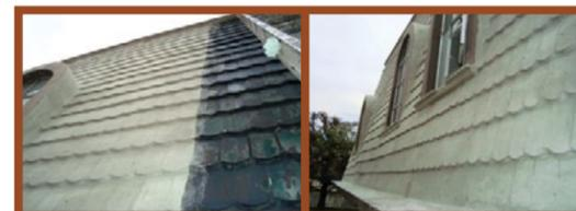
Aplicación de Sellador Texturizado y colocación de Membrana.
