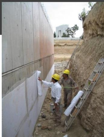
Se realiza la aplicación del **Mortero Acrílico** y fijación de la **Membrana de Refuerzo**.
