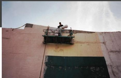
Se sube el rollo de tela en el columpio y de arriba hacia abajo se realiza la aplicación con rodillo del **Mortero Acrílico** y fijación de la **Membrana de Refuerzo**.
