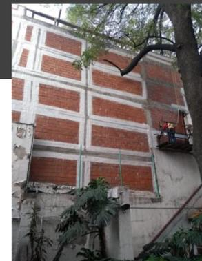
**Evita el aplanado en fachadas, con Imperlasa Impermeabiliza y da Acabado Final.** Solo requieres: buen junteo de tabique, **Sellador Acrílico** en toda la superficie, **Mortero Impermeabilizante Acrílico** como adherente y **Membrana de refuerzo de poliéster** en puntos críticos (uniones de muros con trabes, columnas, castillos, y grietas o juntas abiertas) y acabado **Reflejante Impermeabilizante Acrílico**.
