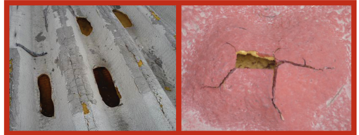
En ocasiones sufre hundimientos al tránsito y forma cavernas por resequead
