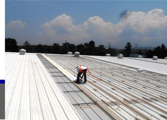
**IMPERLASA** Refuerzo con membrana de poliéster en toda la superficie de lámina metálica con especial cuidado en cumbrera y cabeceras. Acabado elastomérico en toda la superficie. Color a elegir.
