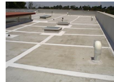
Juntas de Enladrillados
