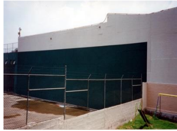
Sello de Muros
